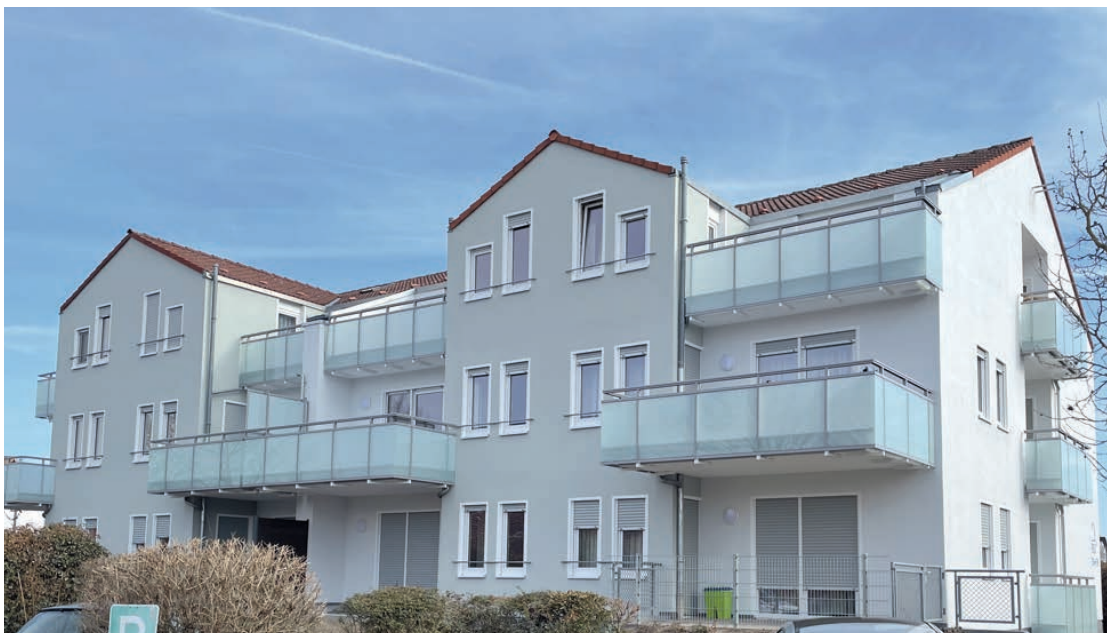
„Wohnen in der Wilhelm-Hamann-Straße“ in Büttelborn-Worfelden
