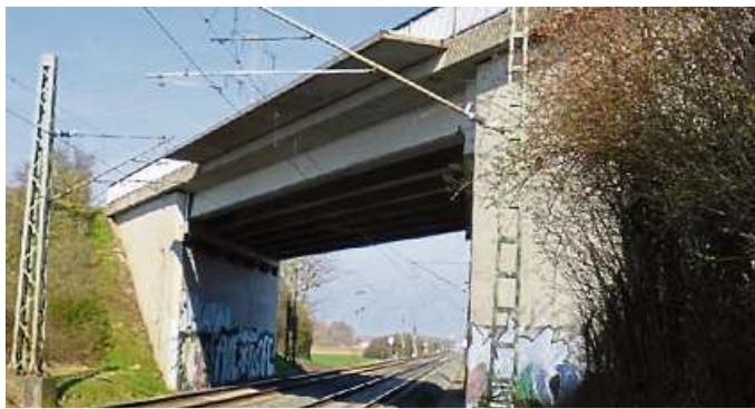
Die Eisenbahnbrücke im Verlauf der K158 nördlich von Wolfskehlen wird Mitte Dezember wieder freigegeben. Foto: Hessen Mobil
