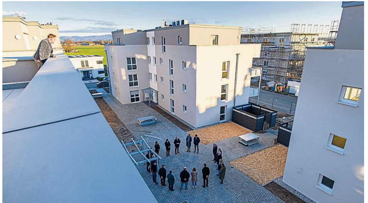
Vom Balkon im Dachgeschoss reicht der Blick, den hier Steffen Hiller genießt, bis zur Bergstraße. Für das Projekt „Wohnen am Quartiersplatz“ hat die BG Ried in Gernsheim vier Häuser mit 38 Wohnungen gebaut. Foto: Robert Heiler
