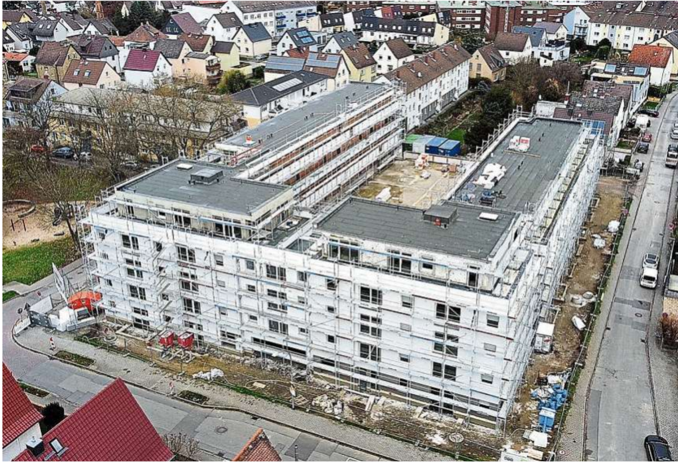
Im Bischofsheimer Theodor-Heuss-Karree entstehen insgesamt 70 Wohnungen.
