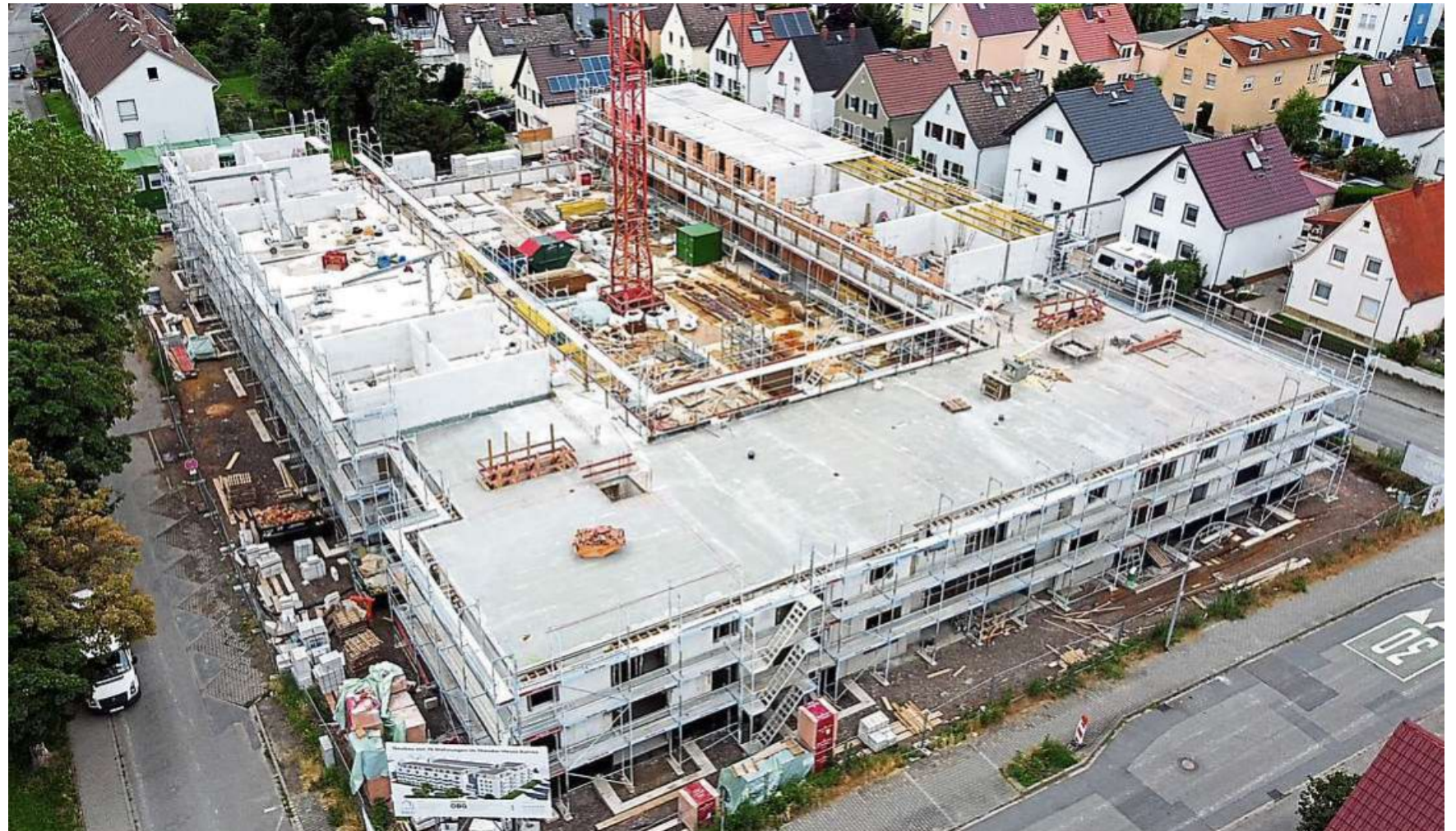
Der Rohbau auf dem früheren Gelände der Theodor-Heuss-Schule ist fast fertig.
