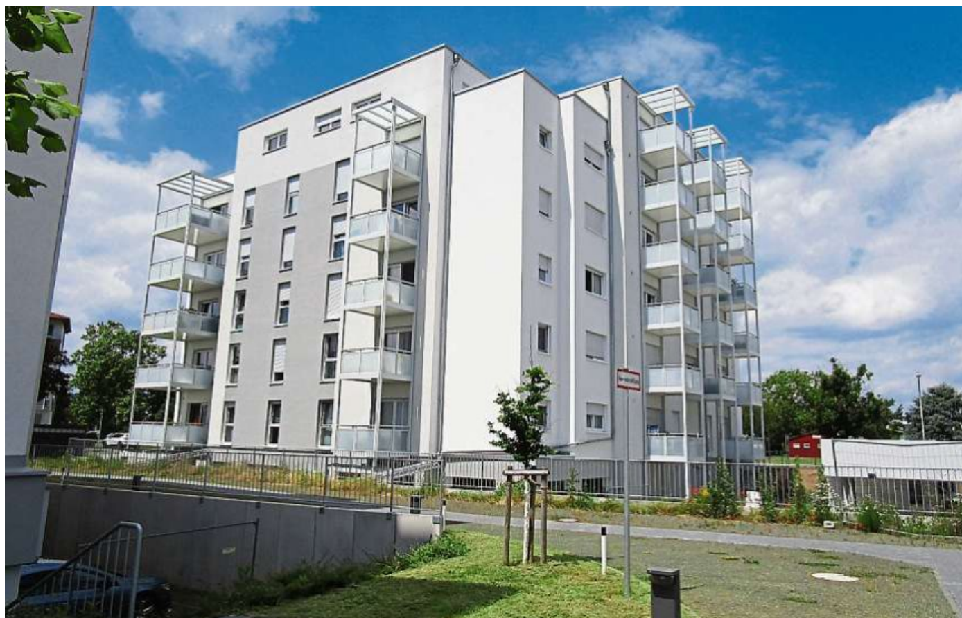
Das Projekt „Wohnen am Rhein“ in Biebesheim soll zum 1. Juli 2024 fertig sein. In die insgesamt drei Häuser mit 133 Wohnungen hat die Baugenossenschaft Ried rund 27,9 Millionen Euro investiert.
